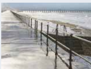
Digue de Luc-Sur-Mer Constructeur métallique : FRAMEIO (Carpiquet - 14)
