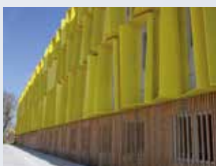
Le TIC - Hub Créatic à Nantes Maître d'ouvrage : Nantes Métropole Aménagement Maître d'œuvre : Cabinet TETRARC Constructeur métallique : EMFA (Les Sorinières - 44)
