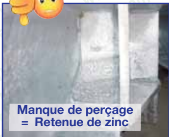
Photos 29 et 30 : Grugeages et perçages
