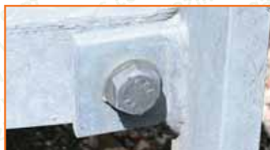
Photo 47 : Boulonnerie galvanisée à chaud par centrifugation en usine (détail sur www.galvazinc.com )
