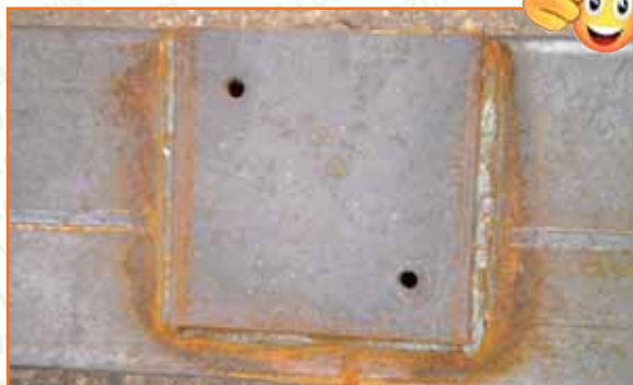
Photo 50 : Trous d'évent et soudure continue
