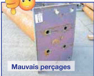
Photos 31 et 32 : Perçages à faire dans l'axe de l'accrochage pour les tubes ronds ou ovales sur platine rectangulaire
